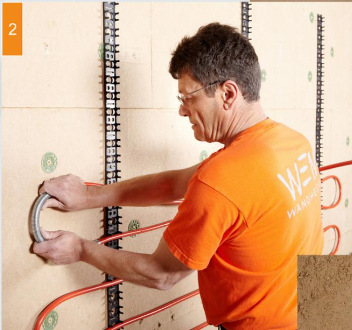
(2) Das Klimarohr wird mit Hilfe einer Biegefeder gebogen und in die Zahnschienen eingeklickt.
