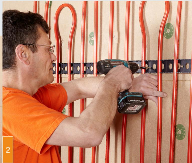
(2) Das nächste Klimaregister wird ebenfalls am Untergrund befestigt und mit dem ersten verbunden.
